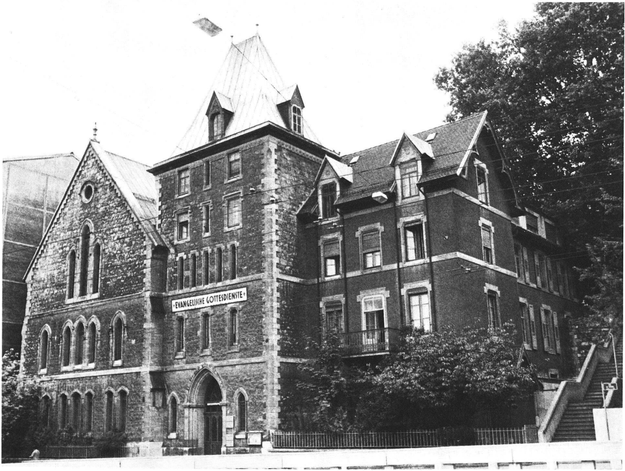
Fig. 8 Chapelle du Valentin, faces sud-est et nord-est. Etat 1983.
