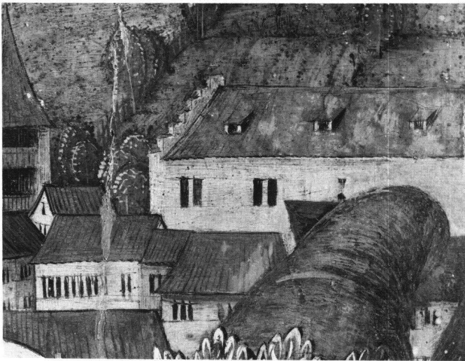
Abb. 20 Detail aus Abb. 15. Das alte oder grosse Zeughaus (vgl. Rechteck in Abb. 15).
