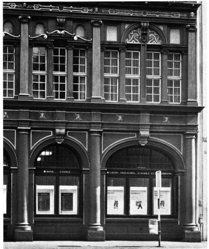
Abb. 10 Basel, Geltenzunft, Detail der Fassade
