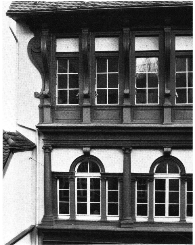
Abb. 1 Basel, Spießhof, Fassadendetail, 3. und 4. Geschöß
