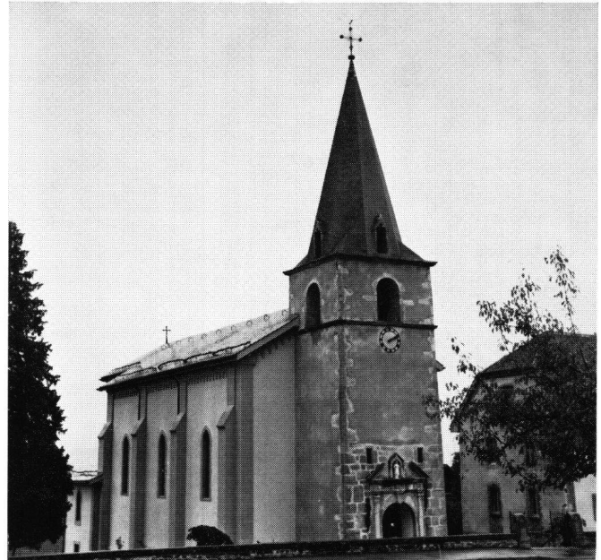
Fig. 2 L'église de Muraz après la restauration. Clocher de 1657 et construction néo-gothique de 1897-1898. A droite, la cure du XVIII e siècle
