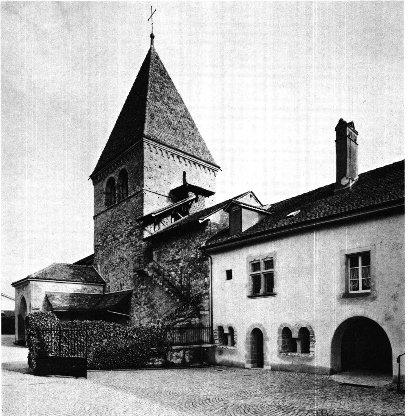
Fig. 21 Les bâtiments conventuels après la restauration
