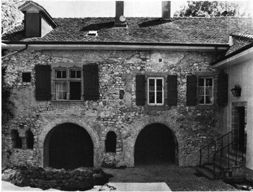
Fig. 2 Vue générale de la façade ouest des bâtiments conventuels durant les travaux de 1971
