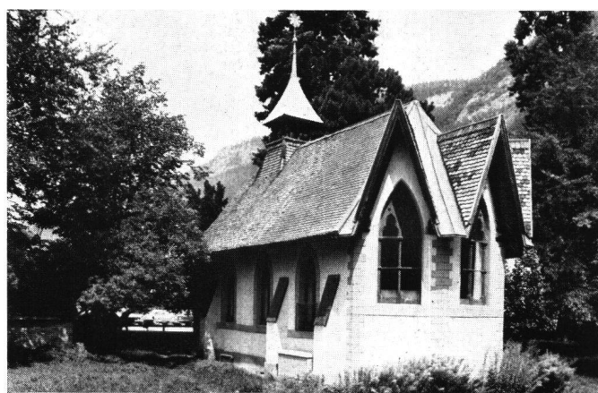
Abb. 16 Meiringen, ehemalige englische Kirche. Außenansicht von Osten
