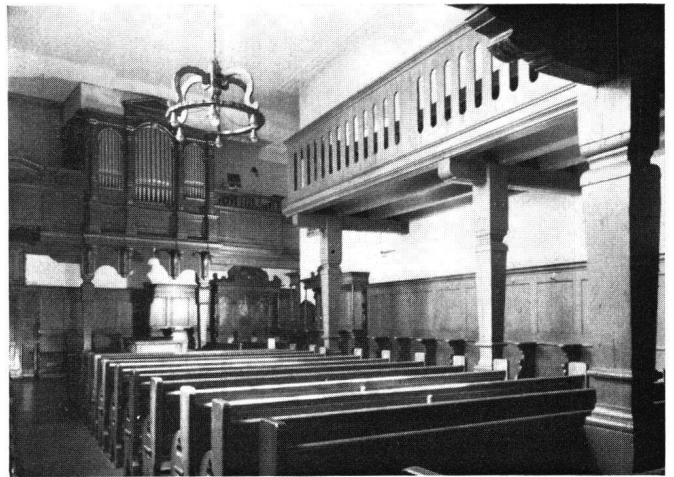
Abb. 6 Binningen, Kirche St. Margarethen. Inneres: Blick vom neuen Südflügel in Richtung Nordostflügel. Zustand vor der Renovation von 1962/63
