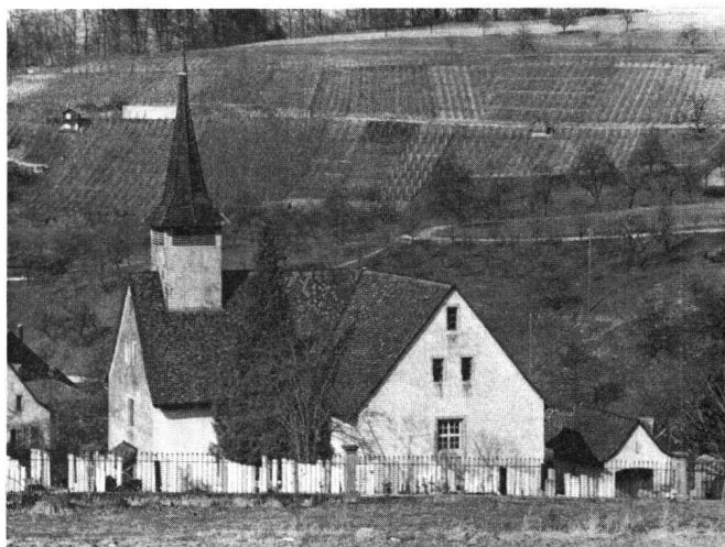
Abb. 9 Wintersingen, Kirche. Südansicht
