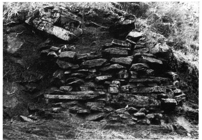
Abb.18 Castello di Tegna. Ansicht der westlichen Stützmauer
