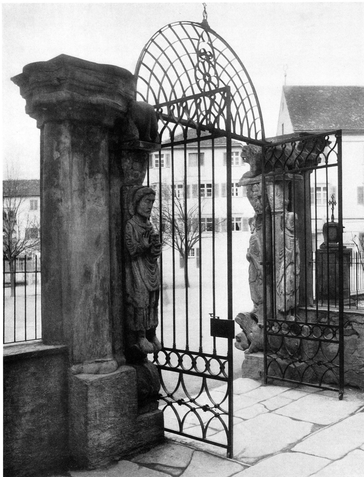
Chur, Dom. – Ehemaliges Vorhofportal von Südosten. Zustand vor 1900
