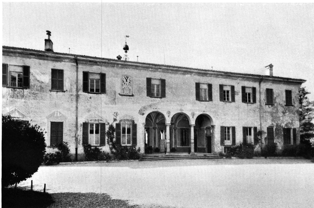
Fig. 14. VILLA DI LOVERCIANO Facciata verso il cortile
