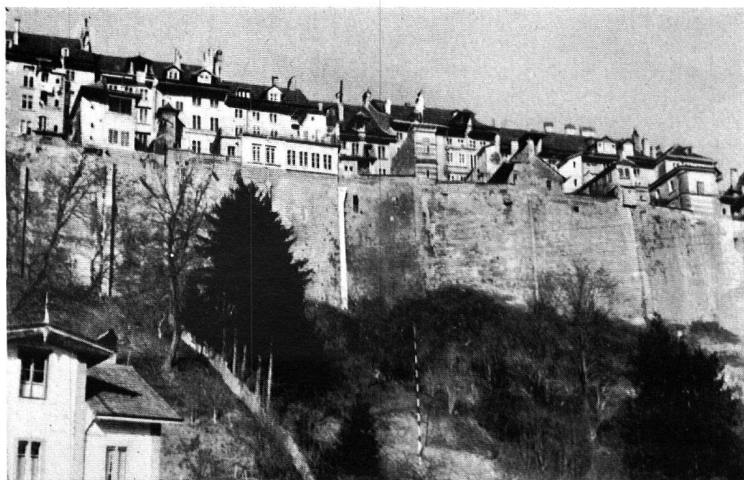
Fig. 9. Murs de soutènement de la Grande-Rue
