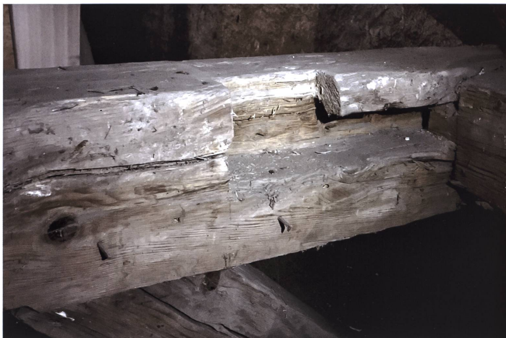
Fig. 10 Hauteville, château, corps central. Couloir taillé dans l'ancien blochet pour l'introduction du linçoir.
