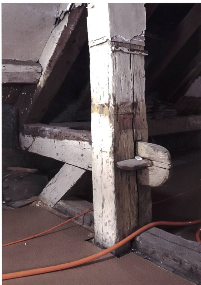
Fig. 5 Hauteville, château, corps central, assemblage blochet-jambe de force par tenon traversant et clavette.
