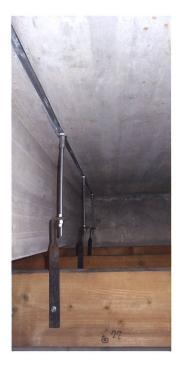
Abb. 31 Deckenaufhängung der Unterkonstruktion mithilfe einer Kombination aus neuen Halfenschienen und alten Stahlankern. Waser-Stube aus der Rosenburg, Stans, Landesmuseum Zürich.
