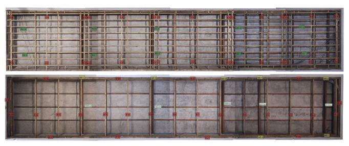
Abb. 14 Beispiel für eine Deckenunterkonstruktion, wie sie vielfach vorgefunden worden ist. Verschiedene Balkenlagen, die im Putz eingelassen oder an den Stahlträgern aufgehängt sind, dienen zur Befestigung der Deckenfüllungen. Decke aus der Kirche Windisch, Landesmuseum Zürich.
