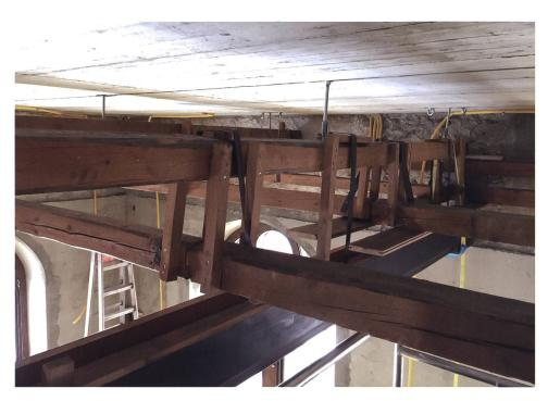
Abb. 32 Deckenunterkonstruktion, die an neuen Halfenschienen an der Betondecke montiert ist. Die Unterkonstruktion ist in sich mit den originalen Metallschlaufen verbunden. Decke aus dem Schloss Arbon, Landesmuseum Zürich.
