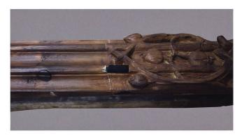
Abb. 7 Fragile Übermalung an einem durch einen Brand zerstörten Deckenbalken. Durch die abgeblätterte Übermalung ist die darunterliegende verkohlte Holzschicht sichtbar. Amtsstube aus der Fraumünsterabtei Zürich, Landesmuseum Zürich.
