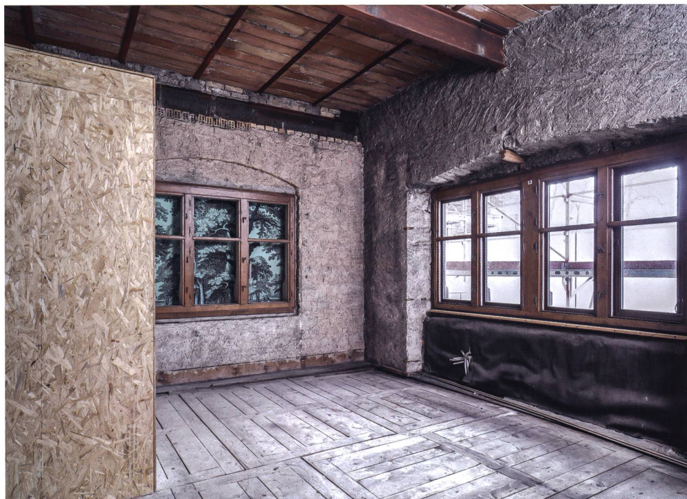
Abb. 21 Komplette verlegter Blindboden, der direkt auf dem Betonboden des Rohbaus aufliegt. Seidenhof-Stube, Landesmuseum Zürich.
