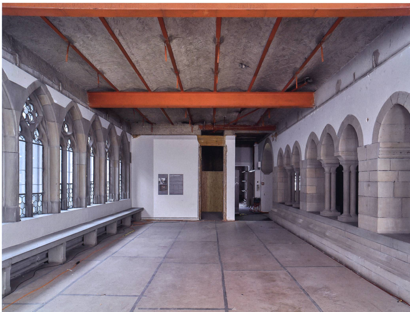
Abb. 26 Originale Betondecke mit Stahlträgern von 1898 nach dem Ausbau der Holzdecke aus der St. Sebastianskapelle, Igels. Oberer Kreuzgang, Landesmuseum Zürich.
