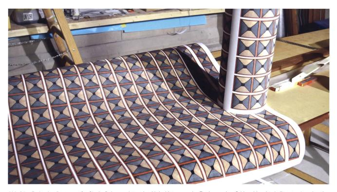
Abb. 36 Gedruckte Papierstreifen für die Rekonstruktion der Abdeckleisten an der Decke aus dem Schloss Neunkirch. Die einzelnen Streifen wurden passend ausgeschnitten und auf die Holzleisten aufgeklebt.
