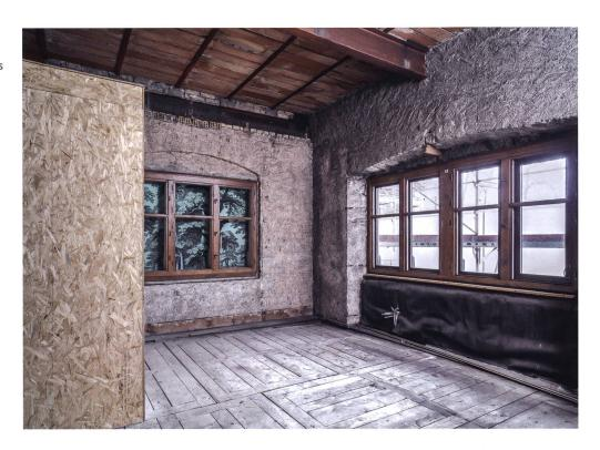
Abb. 22 Lose ausgelegte Leisten und Schifthölzer als Unterlage für die Bodendielen. Wiggen-Stube, Landesmuseum Zürich.
