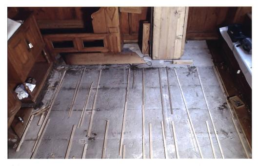
Abb. 22). Die Bodenbretter waren entweder mit Schrauben in der Unterkonstruktion fixiert oder schwimmend verlegt und mit Fremdfedern untereinander verbunden (Amtsstube aus der Fraumünsterabtei).
