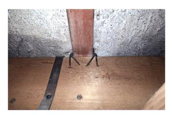
Abb. 16 Fixierung der Unterkonstruktion mit Metalldrähten an den Stahlträgern der originalen Betondecke. Decke aus dem Haus zum Venedigli, Landesmuseum Zürich.
