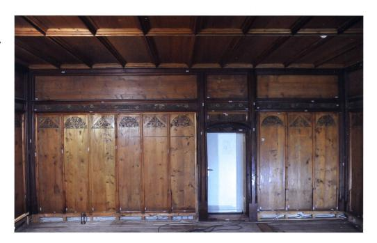
Abb. 2 Teilweise ausgebaute Täfer mit freigelegter Unterkonstruktion, 2016. Oetenbach-Stube, Landesmuseum Zürich.
