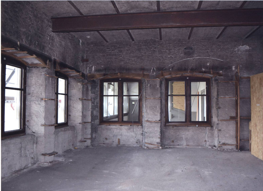
Abb. 30 Zimmer nach dem Ausbau der hölzernen Wandverkleidung und vor der Sanierung. Über und zwischen den Fenstern sowie in den Fensternischen ist die im Raum verbliebene Unterkonstruktion erkennbar. Amtsstube aus der Fraumünsterabtei Zürich, Landesmuseum Zürich.
