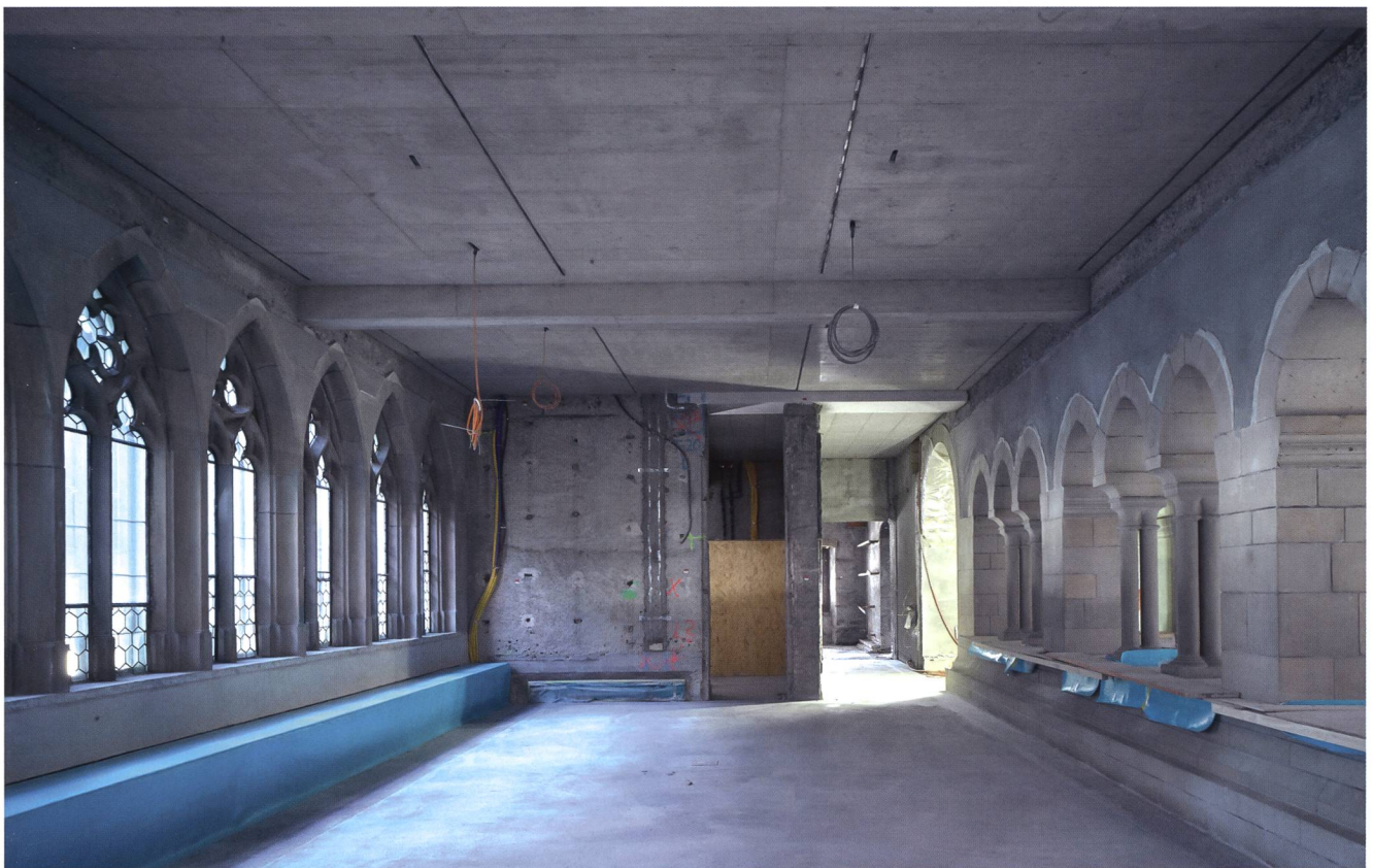
Abb. 27 Neu betonierte Decke und mit Beton ummantelte Stahlträger nach der Sanierung. Oberer Kreuzgang, Landesmuseum Zürich.
