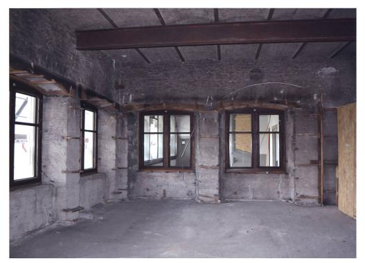
Abb. 30 Zimmer nach dem Ausbau der hölzernen Wandverkleidung und vor der Sanierung. Über und zwischen den Fenstern sowie in den Fensternischen ist die im Raum verbliebene Unterkonstruktion erkennbar. Amtsstube aus der Fraumünsterabtei Zürich, Landesmuseum Zürich.
