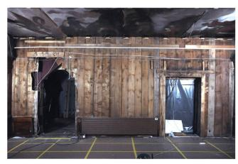
Abb. 13 Komplette Blindtäfelung aus sägerohen Brettern als Unterkonstruktion. Lochmannsaal, Landesmuseum Zürich.
