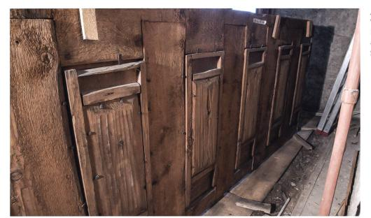
Abb. 3 Rückseite einer Wandverkleidung, welche die Konstruktion und Holzverbindungen offenbart. Seidenhof-Stube, Landesmuseum Zürich.
