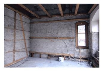
Abb. II Unterkonstruktion aus angeschraubten Latten. Die Riegelwand links im Bild wurde als Bestandteil des Museumsgebäudes ebenfalls als Unterkonstruktion genutzt. Wiggen-Stube, Landesmuseum Zürich
