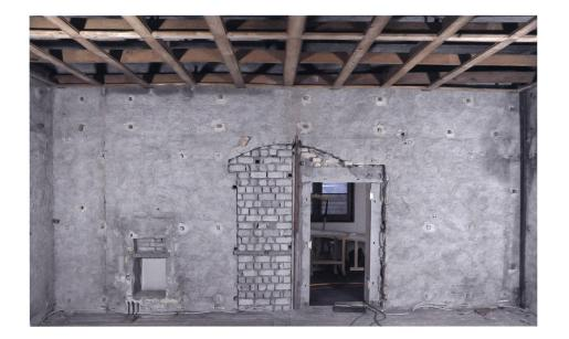
Abb. 3 Raum nach dem Ausbau der Täferwand. An der Decke ist die Unterkonstruktion noch sichtbar, 2016. Oetenbach-Stube, Landesmuseum Zürich.
