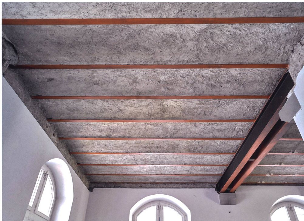
Abb. 28 Originale Betondecke mit Stahlträgern von 1898 nach dem Ausbau der Holzdecke aus dem Haus zur Goldenen Gilge, Zürich. Raum Korridor 00.102.H, Landesmuseum Zürich.
