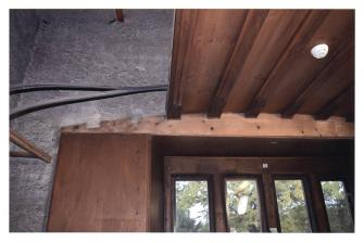
Abb. 18 Deckenbalken und -bretter liegen direkt in den Ausklinkungen der Unterkonstruktion. Helfenstein-Stube aus der Fraumünsterabtei in Zürich, Landesmuseum Zürich.
