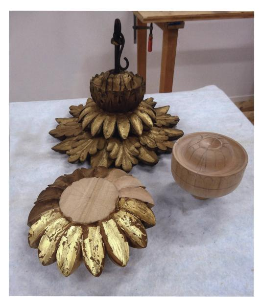
Abb. 37 Originale Rosette aus der Pestalozza-Stube (hinten) und Teile der sich in Arbeit befindenden originalgetreuen Rekonstruktion.
