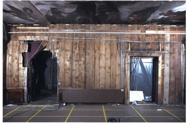
Abb. 13 Komplette Blindtäfelung aus sägerohen Brettern als Unterkonstruktion. Lochmannsaal, Landesmuseum Zürich.
