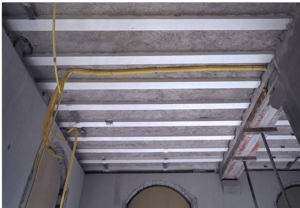
Abb. 29 Neu betonierte Decke und mit Spritzputz als Brandschutz ummantelte Stahlträger nach der Sanierung. Raum Korridor 00.102.H, Landesmuseum Zürich.
