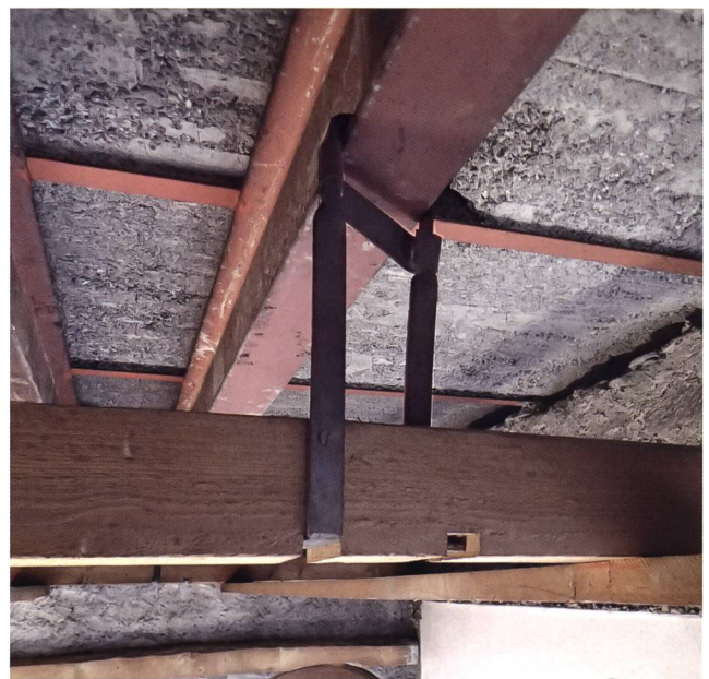
Abb. 17 Befestigung der tragenden Balken der Unterkonstruktion mit Metallbändern an den Stahlträgern. Wiggen-Stube, Landesmuseum Zürich.
