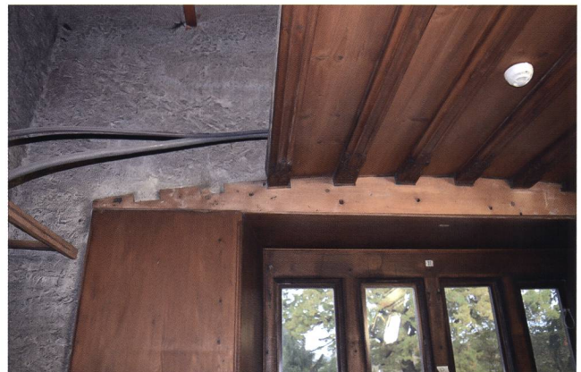
Abb. 18 Deckenbalken und -bretter liegen direkt in den Ausklinkungen der Unterkonstruktion. Helfenstein-Stube aus der Fraumünsterabtei in Zürich, Landesmuseum Zürich.
