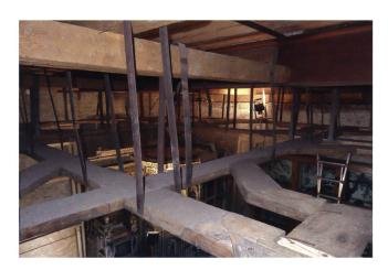
Abb. 15 Befestigung von Deckenelementen mithilfe gebogener Metallbänder. Seidenhof-Stube, Landesmuseum Zürich.
