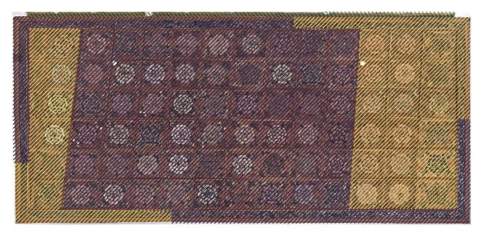
Abb. 9 Kartierung einer photogrammetrischen Aufnahme, die einen Überblick über die noch vorhandenen originalen Bereiche gibt (blau schraffiert). Die gelbe Schraffierung zeigt hinzugefügte Elemente beim ersten Einbau. Grün schraffiert sind umgebaute/angepasste Originalteile. Decke aus dem Mittleren Hof, Stein am Rhein, Landesmuseum Zürich.
