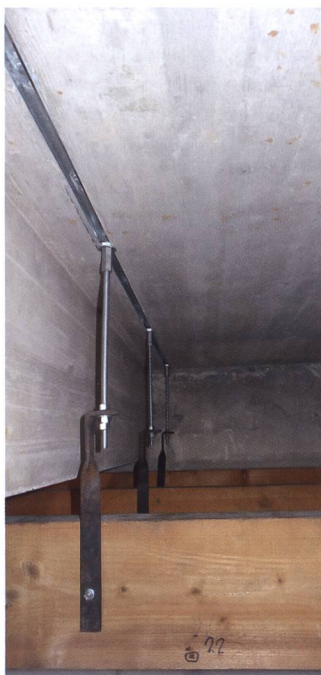
Abb. 31 Deckenaufhängung der Unterkonstruktion mithilfe einer Kombination aus neuen Halfenschienen und alten Stahlankern. Waser-Stube aus der Rosenburg, Stans, Landesmuseum Zürich.
