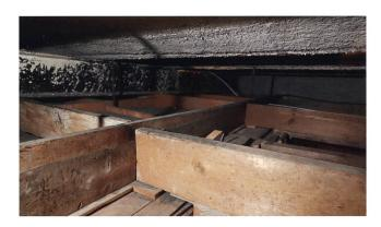
Abb. 40 Blick auf die Unterkonstruktion einer Decke, mit nur wenig Abstand zu den darüber liegenden Stahlträgern. Zu sehen sind die Überblattung der Balken sowie Schiftungen und Verkeilungen der Elemente. Pestalozza-Stube, Landesmuseum Zürich.
