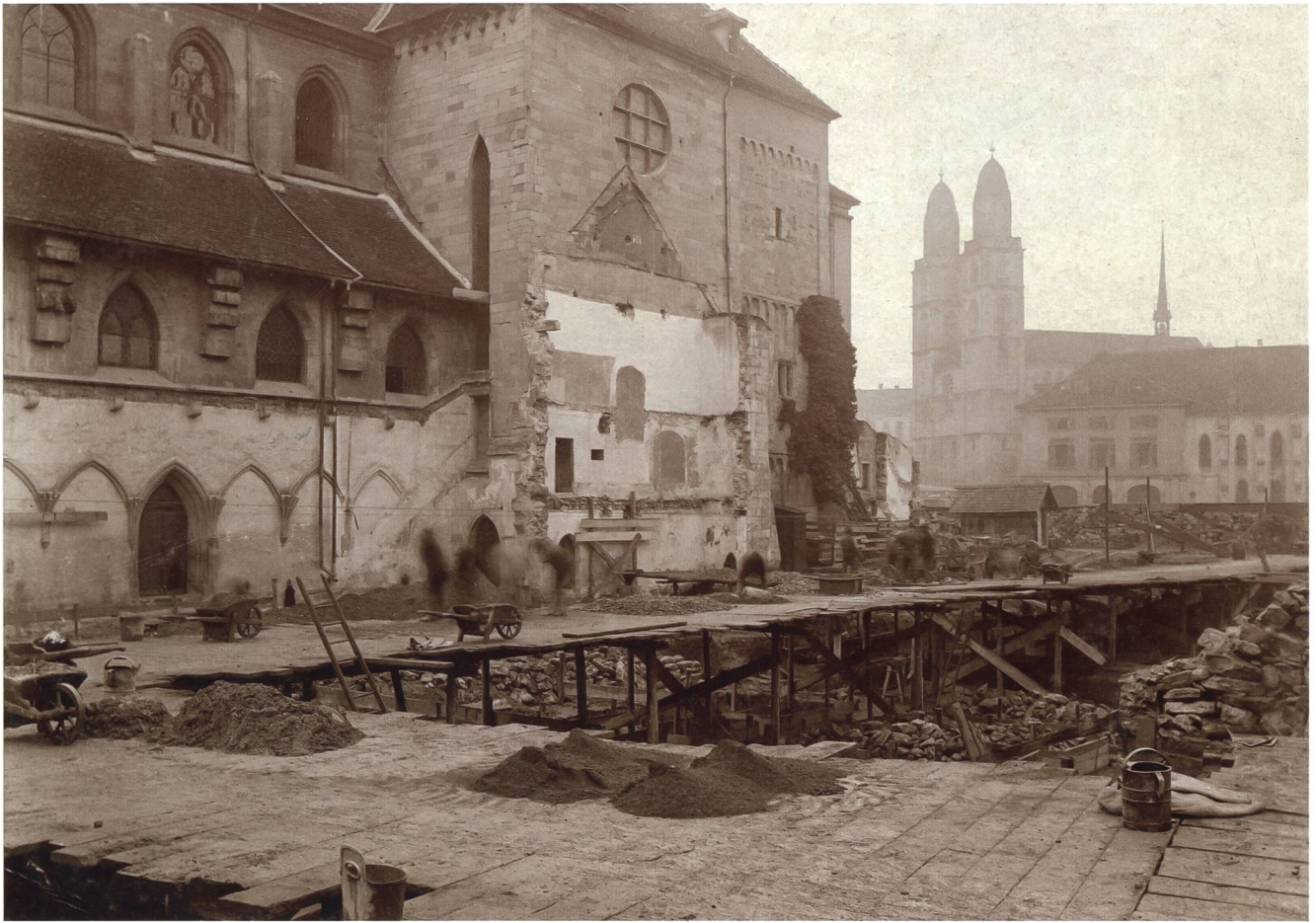
Abb. 7 Areal der einstigen Abteigebäude des Fraumünsterklosters nach dem Abbruch, im Hintergrund die Wasserkirche mit dem Helmhaus und das Grossmünster, Fotografie von Robert Breiting, 23. November 1898. Baugeschichtliches Archiv der Stadt Zürich.
