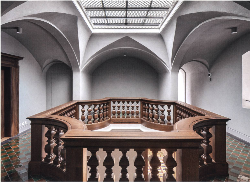
Abb. 5+6 Der wiederhergestellte Deckendurchbruch im Vorraum Obere Kapelle,
