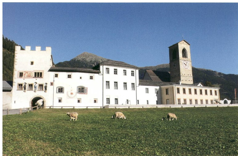
Abb. 4 Müstair, Kloster St. Johann. Ansicht des Klosters gegen Norden mit der Südfassade des Torhauses (links der Mitte) und des Südtorturms (ganz links).
