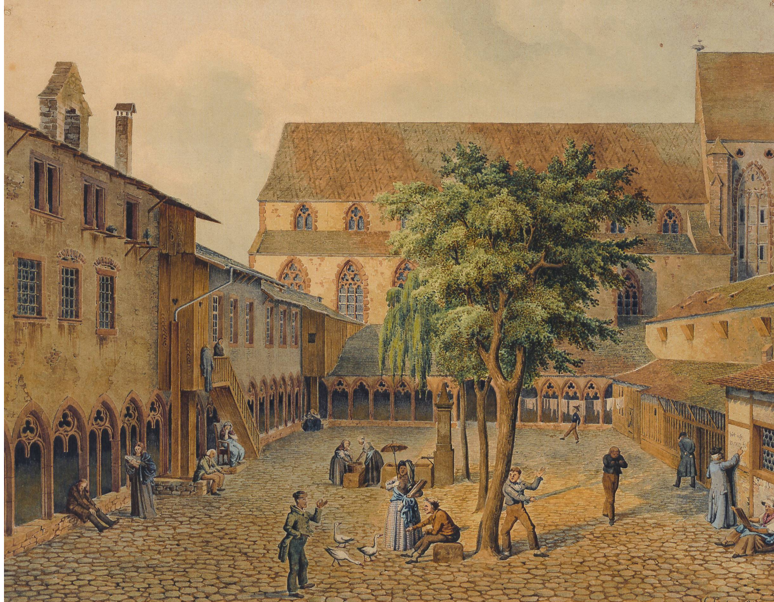
Abb. 10 Die Konventsgebäude und der Kreuzhof dienten nach der Auflösung des Klosters 1529 der Stadt als Irrenanstalt. Der Kreuzhof war der tägliche Aufenthaltsort der «Irren», die ehemaligen Mönchszellen boten Schlafplätze. Das Bild wurde 1849, sechs Jahre nach dem Abbruch der Klostergebäude, von Constantin Guise aquarelliert. Bild: StABS BILD Wack. G 112.
