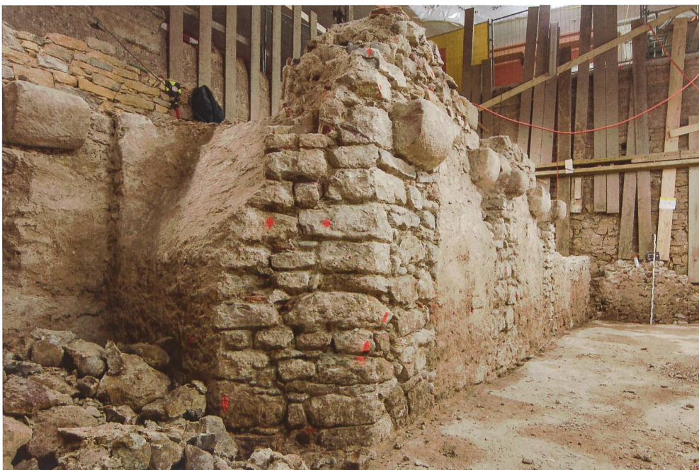
Abb.9 Blick auf die westliche Mauer des Kellers zwischen Stadtmauer und Kapitelhaus. Der Verputz wurde während der Ausgrabung stellenweise abgeschlagen, um den Aufbau des Mauerwerks untersuchen zu können.
