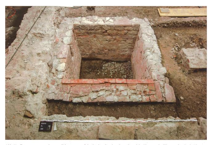
Abb. 11 Der gemauerte und wasserdicht verputzte Schacht einer Latrine, der während der Nutzung der Klostergebäude als Almosen errichtet wurde. Als Baumaterial dienten Ziegel und verschiedenstes Steinmaterial, darunter auch Fragmente alter Grabplatten.
