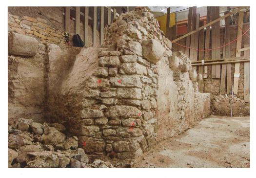
Abb. 9 Blick auf die westliche Mauer des Kellers zwischen Stadtmauer und Kapitelhaus. Der Verputz wurde während der Ausgrabung stellenweise abgeschlagen, um den Aufbau des Mauerwerks untersuchen zu können.
