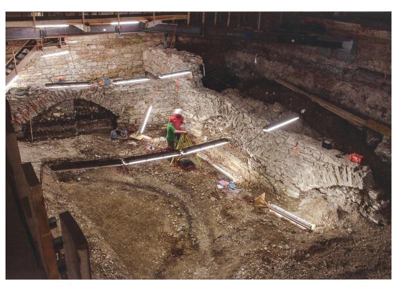
Abb. 6 Blick Richtung Südost auf das Fundament des östlichen und südlichen Kreuzgangflügels mit Entlastungsbögen, die jeweils Distanzen von fast 4m überspannen. Über der Mauerecke verläuft die jüngere Mauer des Kaufhauskellers, im Hintergrund das Fundament der Bühnenapsis des Musiksaals.
