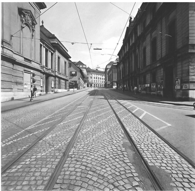
Abb. 31 Ansicht des Steinenbergs von West nach Ost, 1974. Links die östlichste Achse des Musiksaals mit flachverputzter Fassade (ab 1940) und vermauertem Fenster (ab 1967), anschliessend der Hans Huber-Saal. Rechts das Theater mit intaktem originalem Fassadenbild. Fotografie. Staatsarchiv Basel-Stadt, Bildarchiv BSL 1013 1–6447 1. Fotoarchiv Hans Bertolf (1907–1976).
