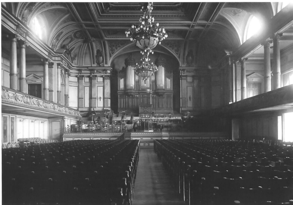
Abb.29 Innenansicht des Grossen Konzertsaals der Neuen Tonhalle in Zürich, um 1897. Fotografie, Baugeschichtliches Archiv der Stadt Zürich 3551. Foto: Moser & Moser Adolf & Moser Stereo.
