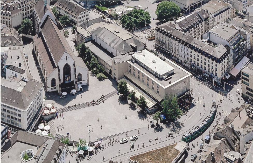
Abb. 33 Schrägluftaufnahme von Nordwesten auf Casino und Musiksaal, 2006. Die Nordseite des Musiksaals mit der seit 1938/39 bestehenden L-förmigen Ummantelung. Am oberen Bildrand der linken Bildhälfte der durch Sprengung des Stehlin'schen Theaters 1975 gewonnene Theaterplatz. Luftaufnahme. Städtebau und Architektur Basel-Stadt, Planungsamt Basel-Stadt.
