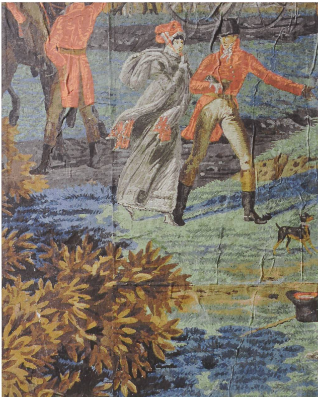
Abb. 18 Detail im Streiflicht aus Bahn 22, Ostwand: Zweitmontage mit teils einzeln verklebten Papierbögen auf einer Unterlage aus Endlospapier, Faltenbildung aufgrund der Auftragsstechnik.
