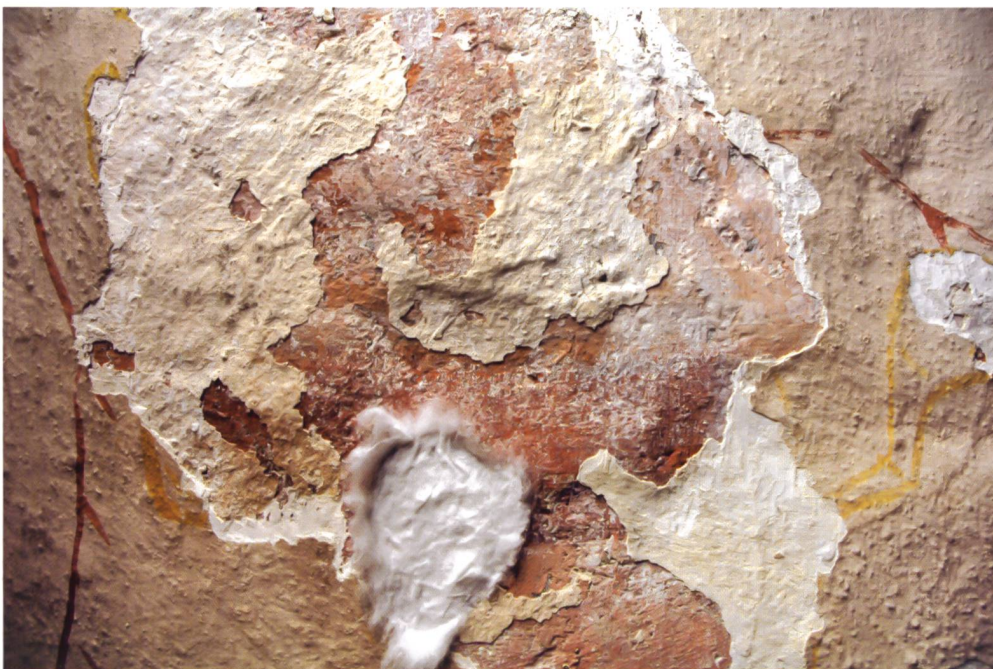
Abb. 15 Abnahme der Deckschichten mittels Kompressenauflage.
