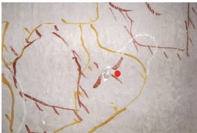
Abb. 14 Südwand, Detail der Hohlstellenkartierung von Oskar Emmenegger.
