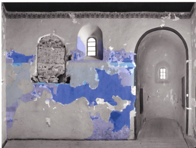
Abb.17 Nordwand mit Kartierung des karolingischen Bestands: Malereiputz sichtbar (dunkelblau), überdeckt (dunkelblau transparent); Vorzeichnungsputz sichtbar (hellblau), überdeckt (hellblau transparent).
