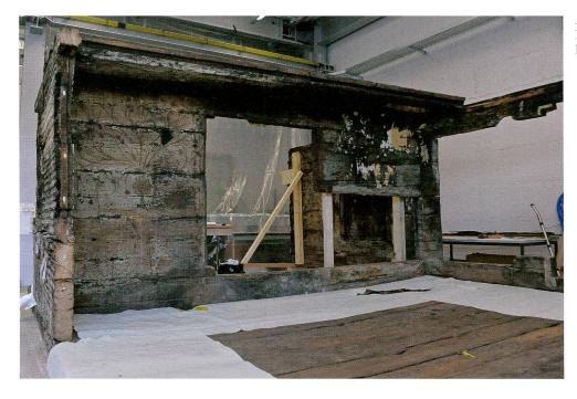
Abb. 5 Wand B mit der ersten Deckenbohle und Deckenbalken.
