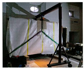
Abb. 10 Kranmanöver beim Absenken von Wand D auf den untersten Balken.
