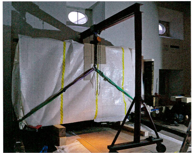
Abb.10 Kranmanöver beim Absenken von Wand D auf den untersten Balken.
