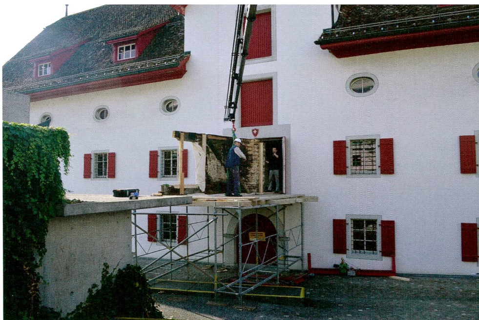
Abb.9 Einbringen des T-Elementes von Wand A/B ins Forum Schweizer Geschichte.
