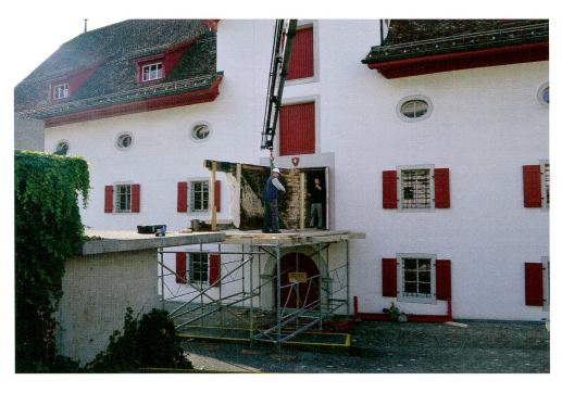
Abb. 9 Einbringen des T-Elementes von Wand A/B ins Forum Schweizer Geschichte.
