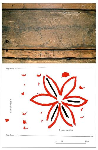
Abb.31 Haus Gütschweg 11. Grosse Stube. Untersicht an die Decke. Abgebeilte Balken und bemalte Bohlen (oben), Pause der Blüten (unten).
