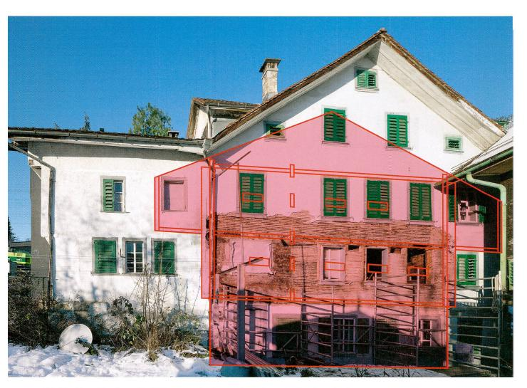
Abb. 22 Haus Gütschweg 11. Südfassade mit rekonstruierter Lage des Kernbaus (rot).
