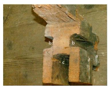
Abb.2 Haus Gütschweg 11. Balkenfragment der Kammerquerwand in aufwendig geschnittener Form. a Eckverbindung, b Nuten für Kämme der Deckenbohlen, c Zapfloch des Türpfostens.
