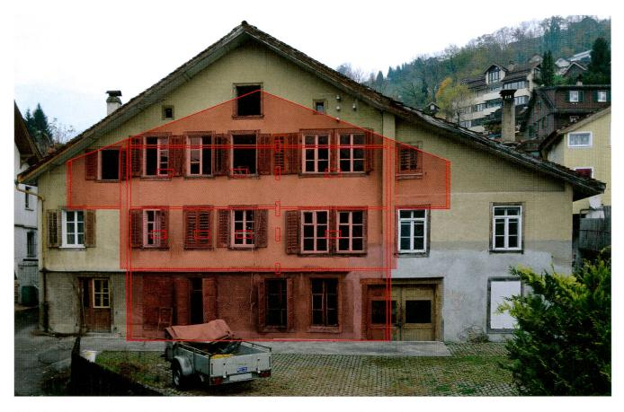
Abb. 19 Haus Gütschweg 19. Südfassade mit rekonstruierter Lage des Kernbaus (rot).
