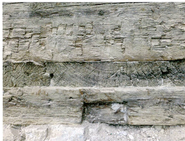
Abb.8 Schwyz, Gütschweg 11. Das Detail der die Fassade durchstossenden Bodenbohle über dem gemauerten Sockel zeigt die handwerkliche Qualität der Zimmerleute in der Zeit um 1300.
