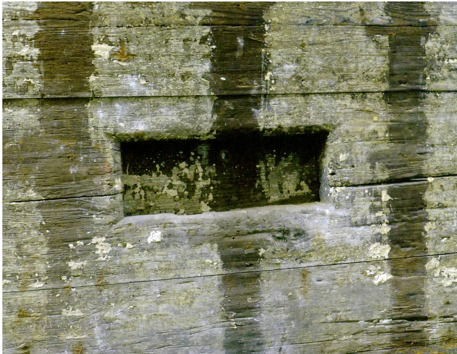
Abb.6 Schwyz, Gütschweg 19. Originale Fensterluke von 1308d mit Schliessladen (nicht vor 1404d).
