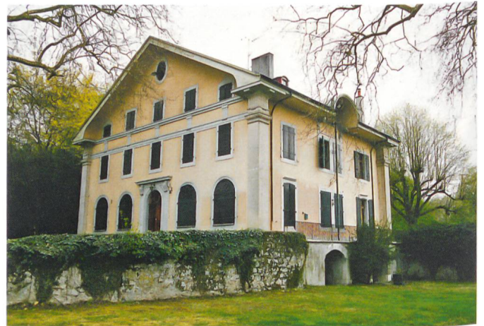
Fig. 11 La maison de maître de l'ancienne propriété Calandrini à Frontenex, en travaux à partir de 1781–1782. Façade sur cour; état avant restauration, avril 2003.
