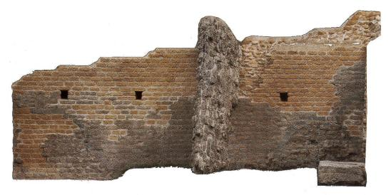
Abb.10 Aventicum/Avenches (VD), théâtre romain. Aditus sud-ouest, mur M90, état après restauration, lacunes comblées avec des moellons en pierre de Metz et rehaussement de la maçonnerie de deux à quatre assises dans le but de protéger le noyauromain et de permettre une bonne évacuation des eaux météoriques, 2013.
