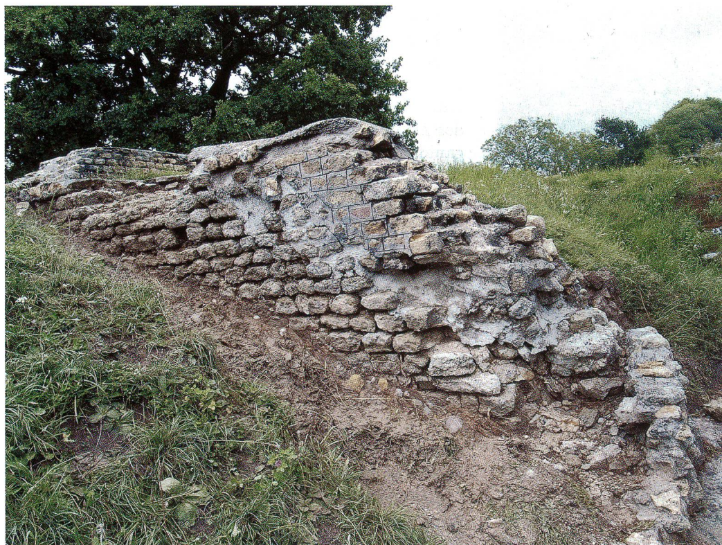
Abb. 6 Avenicum/Avenches (VD), théâtre romain. Arrière corps, mur M66, état après retrait de la végétation, les joints d'origine sont totalement dégradés, des ragréages dans les zones où les pierres sont déjà tombées ont été faits (à la limite entre les parties originales et les restaurations du 19 ème siècle), 2009.
