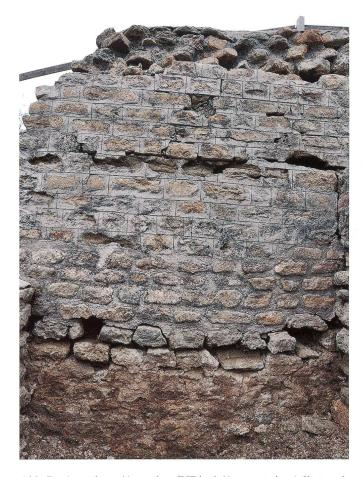
Abb. 7 Aventicum/Avenches (VD), théâtre romain. Aditus sudouest, mur M83, état après retrait de la végétation et dégagement de sa base, pierres profondément érodées, la première assise dégradée se trouvait au niveau du terrain, la seconde assise, entourée de ciment, a subit des dégâts dus au gel en raison de sa plus grande perméabilité, 2009.
