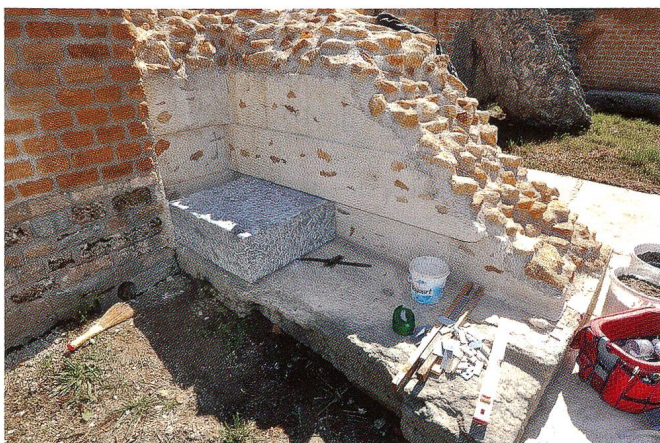
Abb. 14 Aventicum/Avenches (VD), théâtre romain. Aditus sud-ouest, côté nord du mur M93, négatifs des blocs en gros appareil, travaux en cours, 2013.
