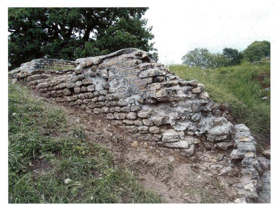
Abb.6 Aventicum/Avenches (VD), théâtre romain. Arrière corps, mur M66, état après retrait de la végétation, les joints d'origine sont totalement dégradés, des ragréages dans les zones où les pierres sont déjà tombées ont été faits (à la limite entre les parties originales et les restaurations du 19ème siècle), 2009.
