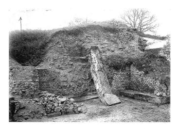
Abb. 2 Aventicum/Avenches (VD), römisches Theater. Südwest-Aditus während der Freilegungsarbeiten im Jahre 1898. Deutlich sind die weitgehend demontierten Mauerschalen und das grossflächig exponierte Kernmauerwerk der Ruine zu erkennen. Blick von Norden.
