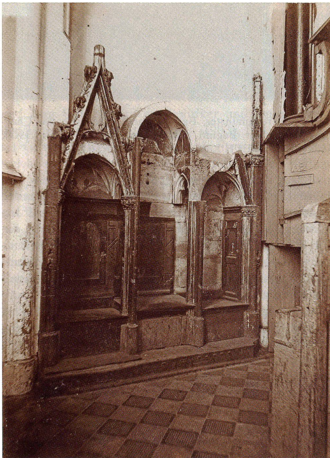
Abb. 4 Verenamünster, Bad Zurzach. Fotografie der Sedilien vor Beginn der Restaurierung im Jahr 1900. 16,8 × 23 cm. ETH Zürich/Archiv gta.
