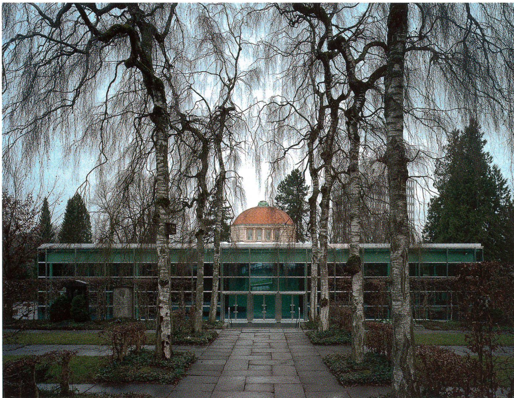
Abb. 8 Neue Abdankungshalle von Alfons Barth und Hans Zaugg (1968), Friedhof Rosengarten, Aarau. Fotografie: Walter Mair, 2009. Kantonale Denkmalpflege Aargau.
