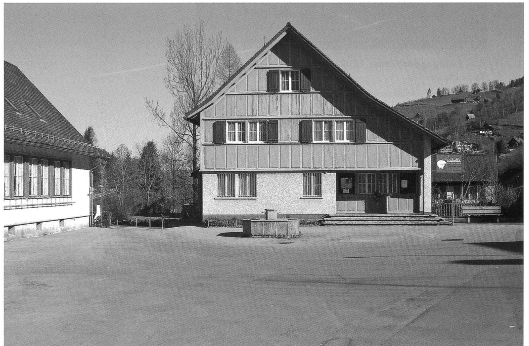
Abb. 17 Stein SG, Wiederaufbau nach Dorfbrand gemäss einem Projekt von Max Kopp für die Bauberatungsstelle des Schweizer Heimatschutzes, ausgeführt ab 1948, Aufnahme 2007.
