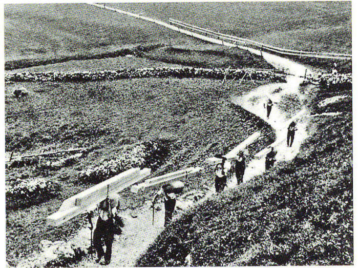
Abb.2 Ein transportables und handliches Baukastensystem: Holzbalken für den Strickbau.
