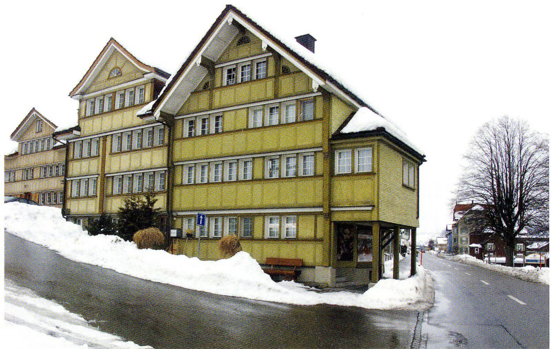
Abb.29 Kompromiss zwischen Hausbestand und neuer Strassenverbreiterung: Aufständigung des Obergeschosses mit Gehweg darunter, an der Strasse zwischen Herisau und Speicher.
