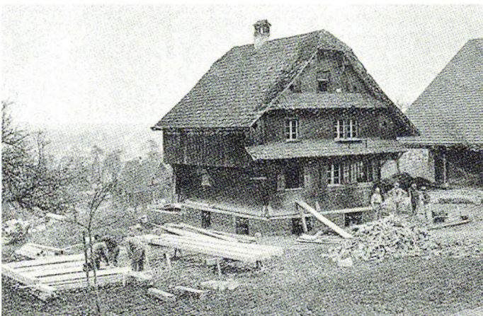
Abb.17 Das Bauernhaus auf dem Reussbühl nach der Verschiebung auf seinem neuen Sockelgeschoss, um 1928.
