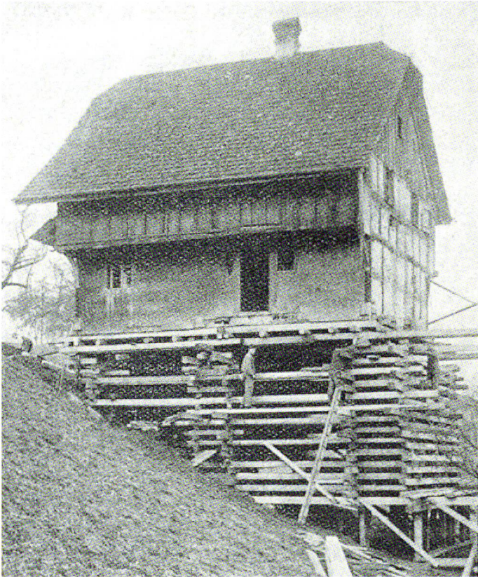
Abb.16 Ein Bauernhaus auf dem Reussbühl bei Emmenbrücke (Luzern) während der Verschiebung, um 1928.
