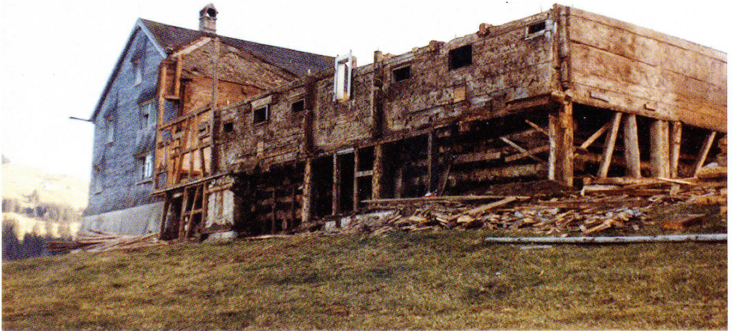
Abb.35 Haus Brülisau während der Demontage, um 1984.
