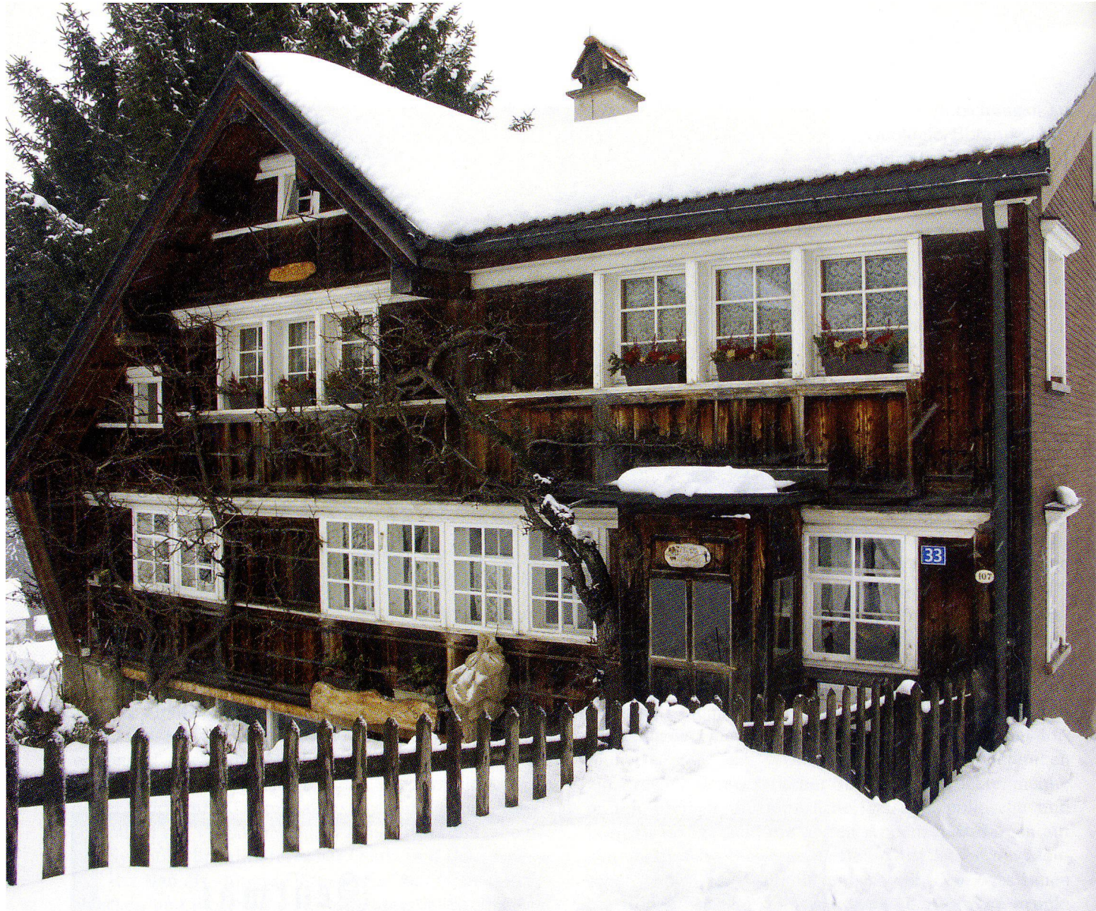
Abb.10 Die «förene Hütte» im heutigen Zustand.
