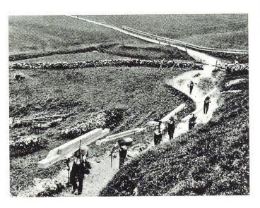
Abb.2 Ein transportables und handliches Baukastensystem: Holzbalken für den Strickbau.
