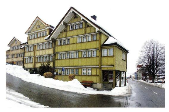
Abb. 29 Kompromiss zwischen Hausbestand und neuer Strassenverbreiterung: Aufständerung des Obergeschosses mit Gehweg darunter, an der Strasse zwischen Herisau und Speicher.
