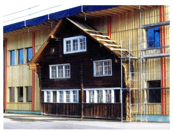
Abb. 48 Wiederaufbau der Fassade des ehemaligen Hauses Egger aus Unterwolfheiden an die Werkhalle des Holzbetriebes Nägeli in Gais.
