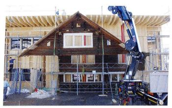
Abb. 44–47 Demontage des Hauses Egger in Unterwolfheiden und Translozierung der Bauteile zur Werkhalle des Holzbetriebes Nägeli nach Gais.
