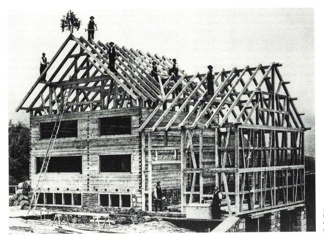
Abb.3 Die Zusammensetzung der Strickbauelemente.
