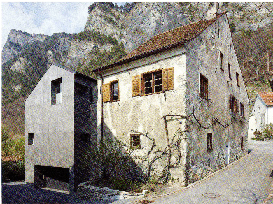
Abb. 13 Casascura, Wohnhaus von Kurt Hauenstein mit Ergänzungsbau von 2007, Sichtbeton als modernes Pendant zum Steinbau aus dem 18. Jahrhundert, Fotos 2009.
