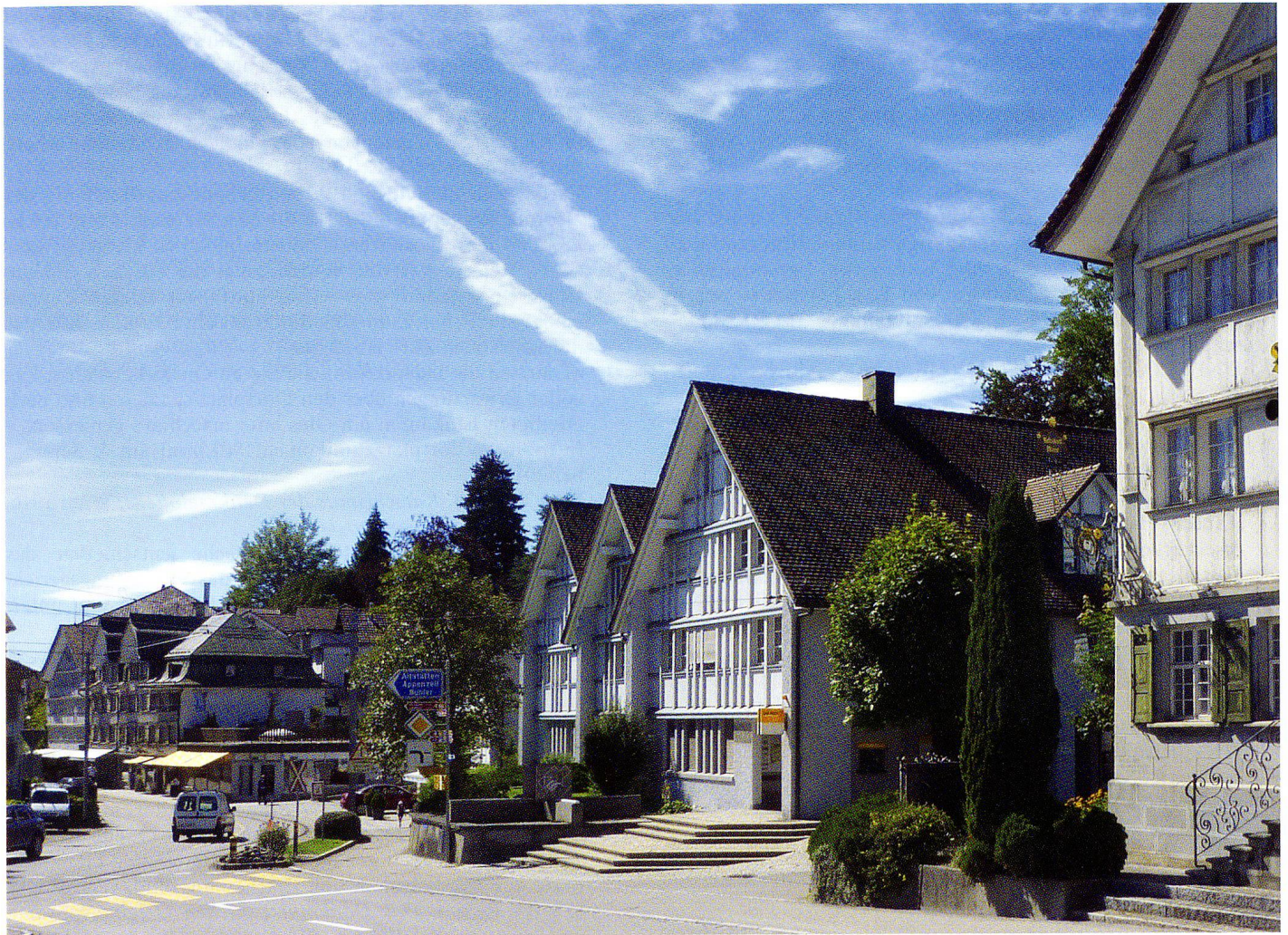
Abb.25 Teufen. Die 1978 von Hans Ulrich Hohl erbaute Post ist auch aus heutiger Sicht noch ein gelungener Kompromiss zwischen Einpassung und Eigenständigkeit.
