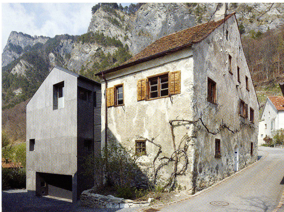
Abb. 13 Casascura, Wohnhaus von Kurt Hauenstein mit Ergänzungsbau von 2007, Sichtbeton als modernes Pendant zum Steinbau aus dem 18. Jahrhundert, Fotos 2009.
