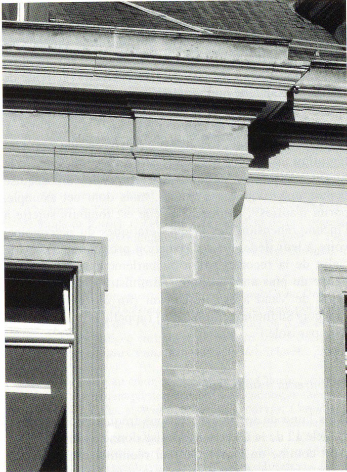
Fig.5 Ancienne Ecole de chimie de Lausanne, détail d'une chaîne d'angle après « rénovation douce ».
