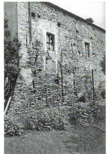
Fig. 4: Resti dell'antica parete meridionale con tracce di lesene.
