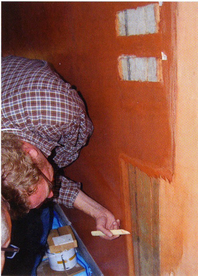
Fig. 8 Essais d'enlèvement de la couche de peinture à l'huile rouge recouvrant un décor en détrempe sur papier à Attingham Park (Shropshire)
