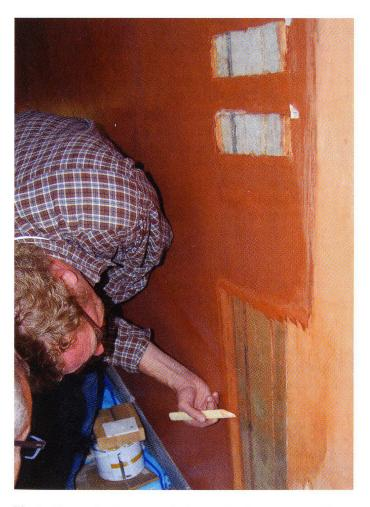
Fig. 8 Essais d'enlèvement de la couche de peinture à l'huile rouge recouvrant un décor en détrempe sur papier à Attingham Park (Shropshire)
