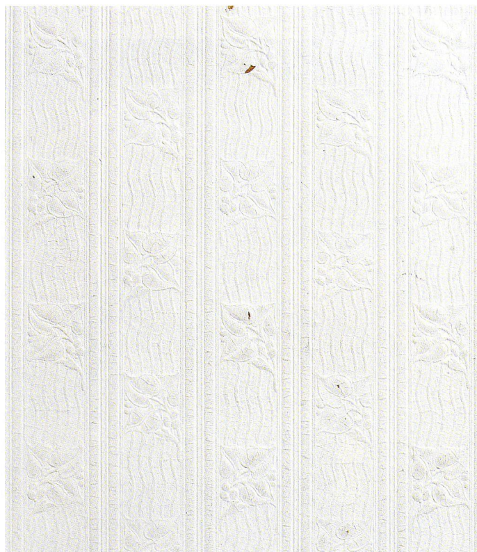
Fig. 6 Papier peint original (surpeint en blanc) recouvrant le bas des murs de la cage d'escalier.
