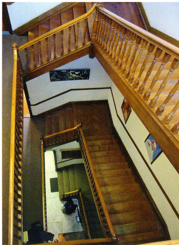
Fig. 5 Cage d'escalier avant restauration.
