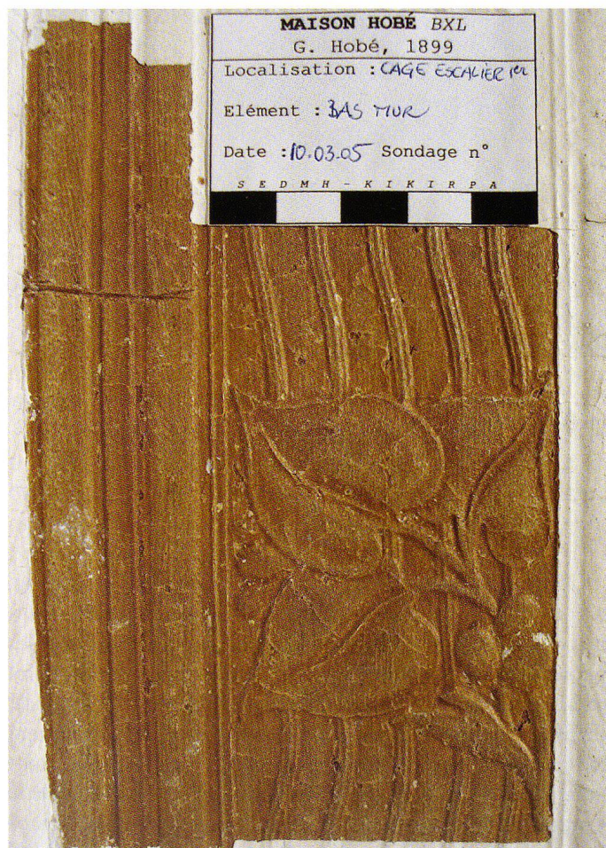
Fig. 8 Dégagement de la finition originale du papier peint recouvrant le bas des murs de la cage d'escalier.
