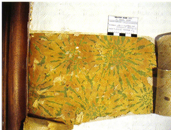
Fig. 11 Sondage mettant au jour le papier original du plafond de la salle à manger du premier étage.
