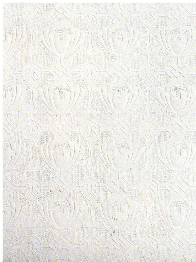
Fig. 7 Papier peint (surpeint en blanc) recouvrant le haut des murs de la cage d'escalier.
