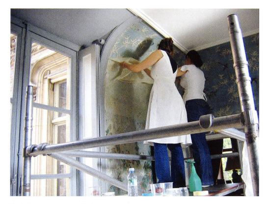
Fig. 9 Le nettoyage par capillarité.
