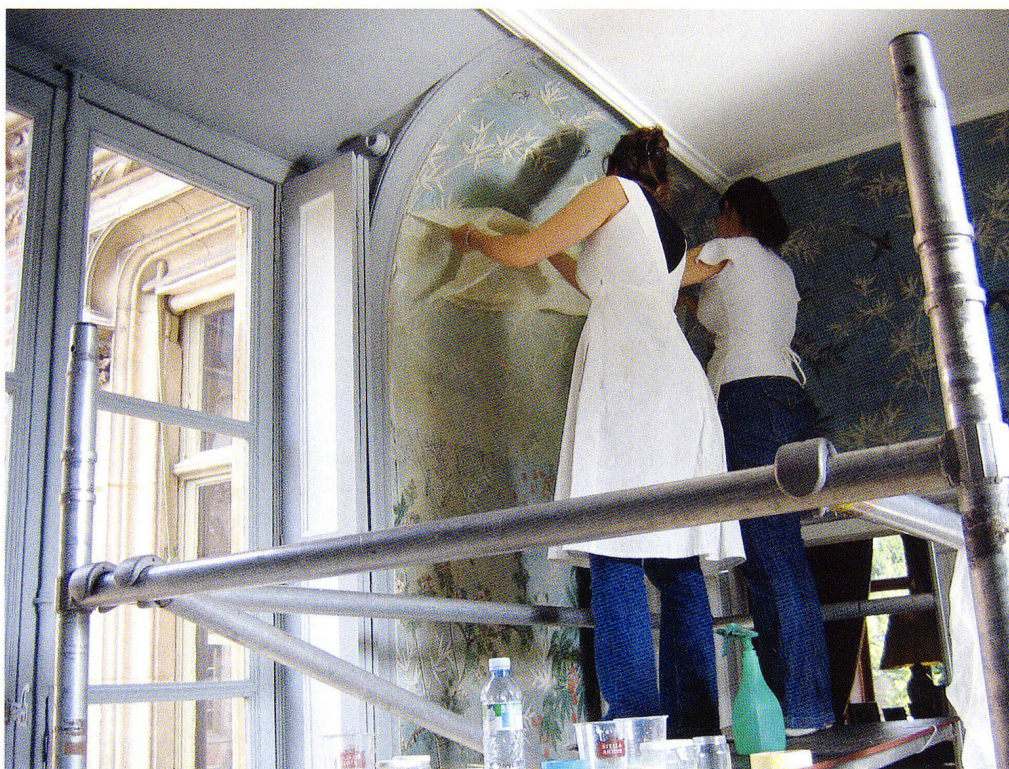
Fig. 9 Le nettoyage par capillarité.
