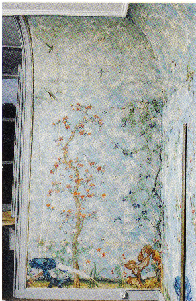
Fig. 3 Le mur avant dépose.
