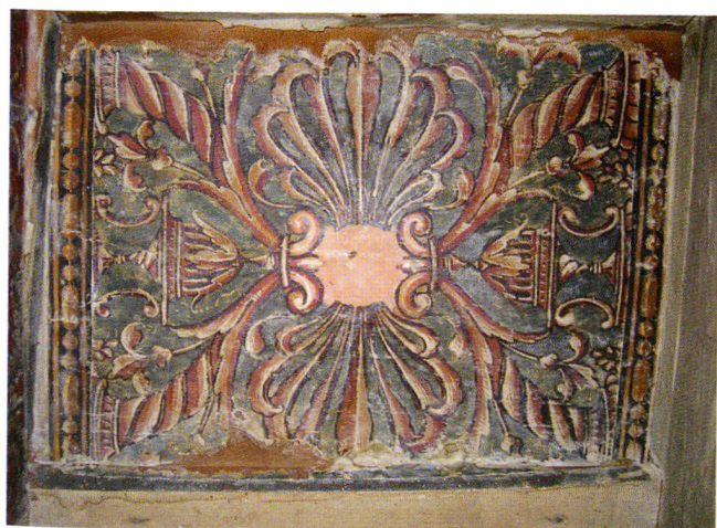
Fig. 10 Détail de la décoration des caissons.
