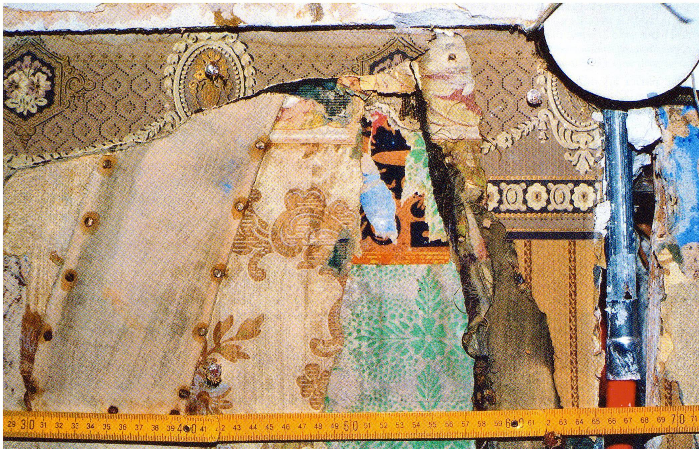
Abb. 1 Einige von ursprünglich acht Tapetenschichten in einem Raum des Hattstätterhofs Basel, Situation 2005.
