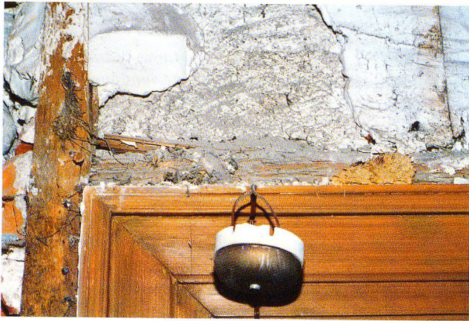
Abb. 13 Beispiel eines Spannrahmens mit Nägeln und Überresten der Trägerleinwand, 2005, Hattstätterhof Basel.
