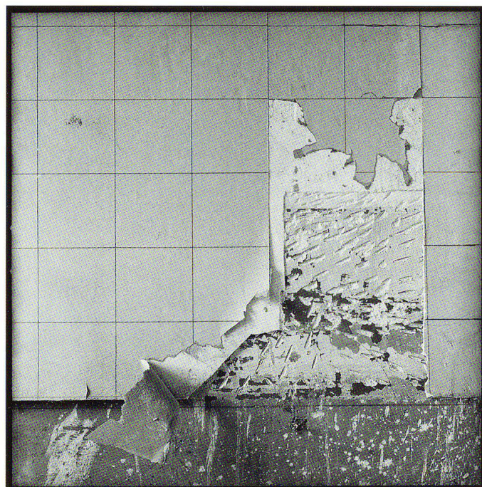
Fig. 14 Vue d'intérieur du Château de Prangins en travaux (salle 1114), 1991. Photographie de Jean-Marc Yersin. Archives du Château de Prangins.
