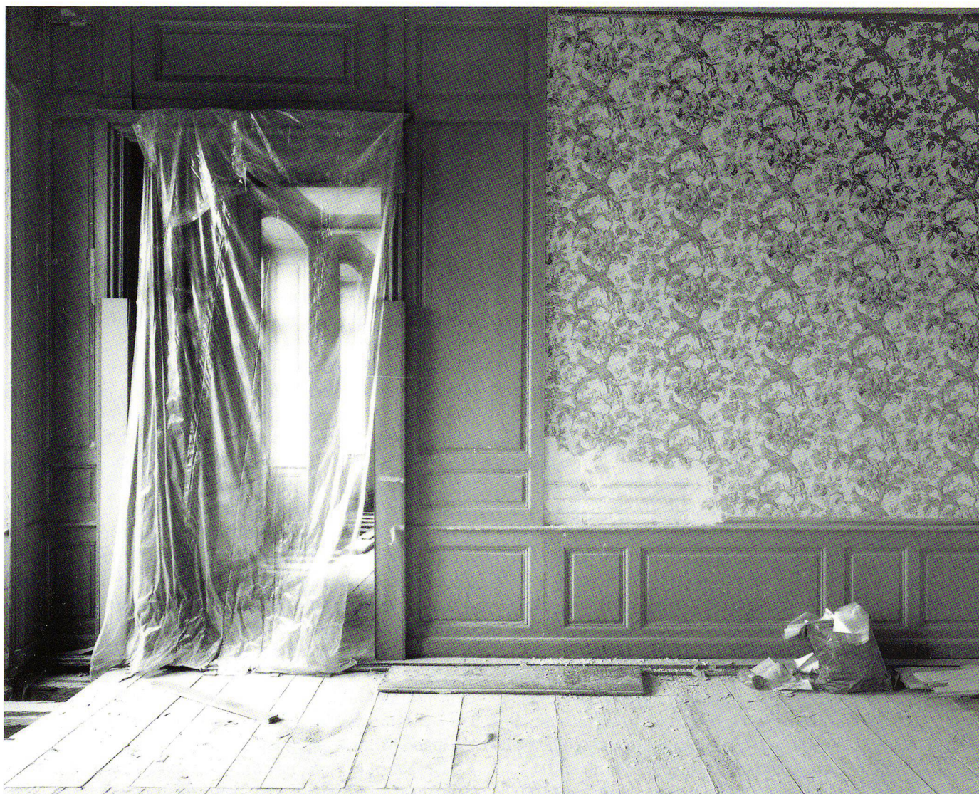
Fig. 1 Vue d'intérieur du Château de Prangins en travaux (salle 1111), 1991. Photographie de Jean-Marc Yersin. Archives du Château de Prangins.
