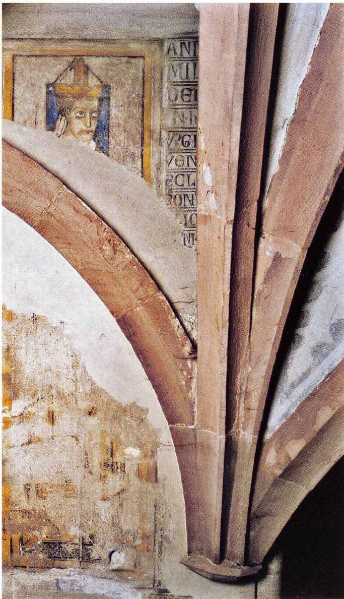
Abb. 2 Basler Münster, Ostkrypta, Bischof Lüthold von Aarburg. Er war der Stifter des Marienaltars in der Krypta. Dank der durchbrochenen Gewölbekappe und dem entnommenen Auffüllschutt sind seit 1974 die Kopfpartie des Bischofs und die anschließende Inschrift wieder sichtbar.
