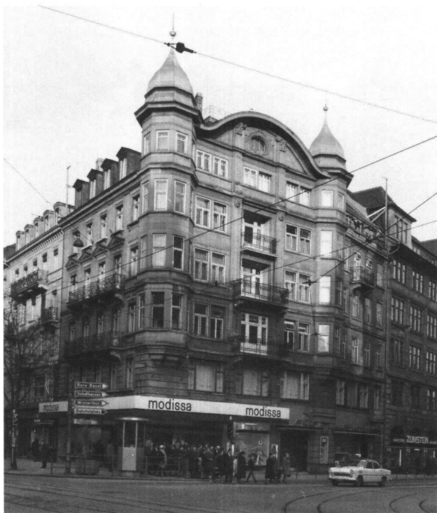
Abb. 19 Silberhof. Aufnahme kurz vor Beginn der Abbrucharbeiten, bereits mit Baugespann für den Neubau «Modissa».
