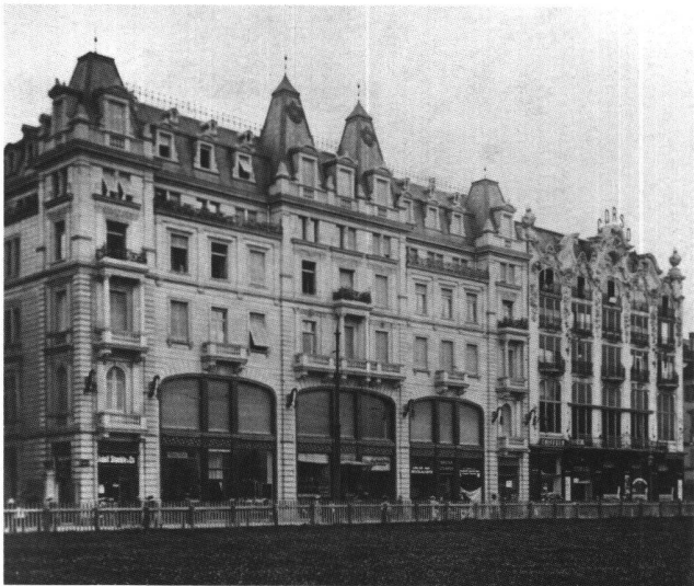
Abb. 17 Wohn- und Geschäftshaus Theaterstrasse 12. Aufnahme um 1910.
