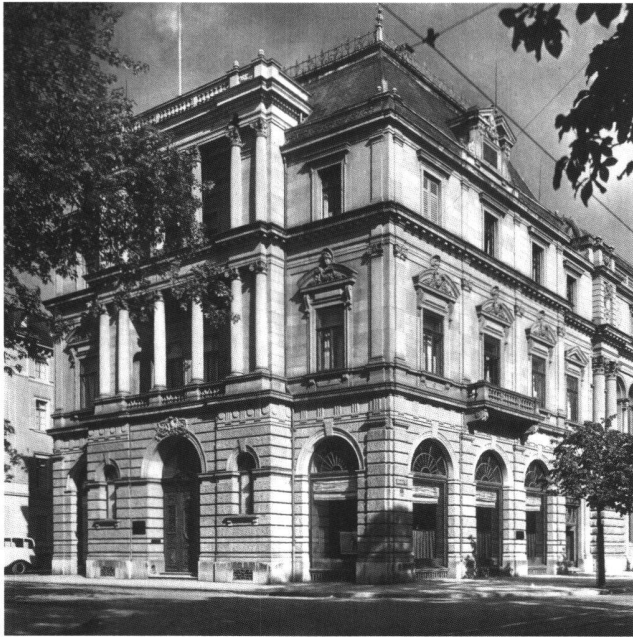
Abb. 15 Palais Abegg-Arter, rechts anschliessend die alte Börse noch vor der Purifizierung. Die Übernahme der Geschosshöhen vom Börsengebäude war eine Auflage beim Bau des Palais. Aufnahme 1929.
