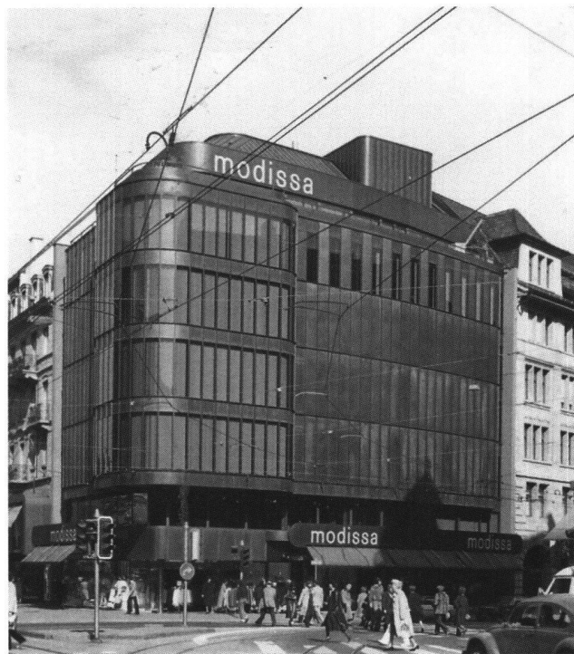
Abb. 20 Dieselbe Strassenecke mit Neubau von Werner Gantenbein. Aufnahme 1981.
