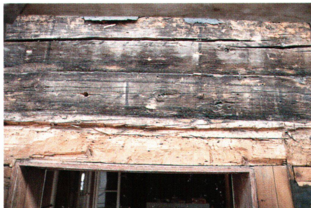
Abb. 18 Menzingen, Hauptstrasse 6: Reste der Quaderimitation an der Südfassade über dem ersten Obergeschoss. Darunter die fassadensichtigen Bretter der Decke über dem ersten Obergeschoss. Blick nach Norden.
