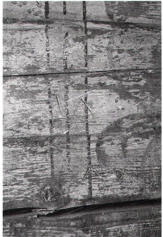
Abb. 22 Menzingen, Hauptstrasse 6: 1535 übermalte, eingekerbte Zahlzeichen («Abbundzeichen») an der Westwand der Kammer im ersten Obergeschoss, Blick nach Westen.
