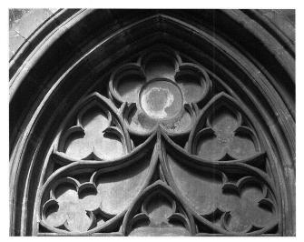
Abb. 12 Prag, Veitsdom. Blendmasswerk über der Sakristeipforte.
