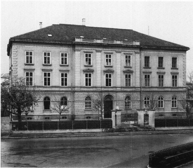
Abb.20 Staats- und Bankgebäude Chur, Architekt Johannes Ludwig, erbaut 1877/78.
