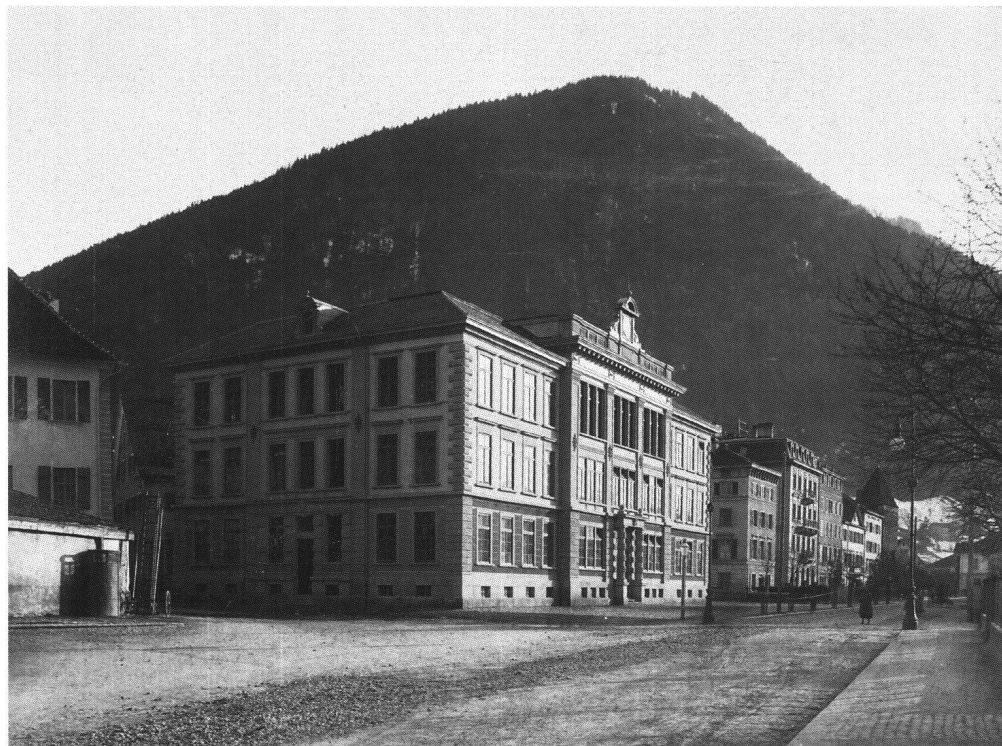
Abb. 18 Grabenschulhaus Chur, um 1900.
