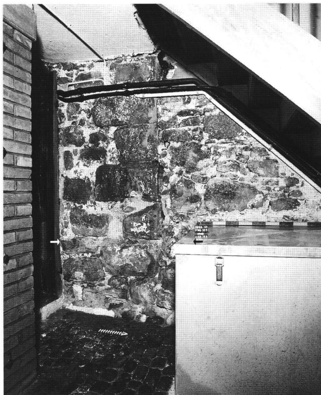
Abb. 8 Blick auf die Nordostecke des 1265/66 errichteten Steinbaus D. In der Bildmitte ist deutlich der Eckverband aus sauber zugeschlagenen Buckelquadern zu sehen. Der unterste Buckelquader liegt rund 2,15 Meter über dem Fundament. Der Pfeil markiert die horizontale Begrenzung der Brandrötung, die gut 2,75 Meter über dem Fundament liegt. Von rechts stösst die bei der 1615/17 erfolgten Erweiterung gebaute Hausmauer an die Ecke an.
