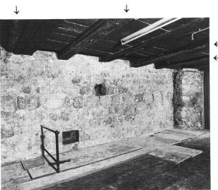
Abb. 13 Inneres des Steinbaus D von 1265/66. Die mit Pfeil markierten Balken datieren von 1265/66. Sie sind bislang die ältesten noch in Funktion stehenden Deckenbalken in der Winterthurer Altstadt.
