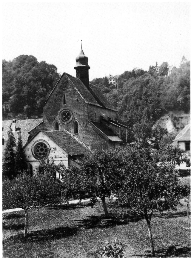
Abb. 1 Magerau, Zisterzienserinnenkirche, Ansicht von Nordosten.
