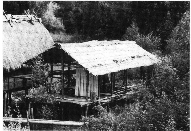
Abb. 2 Nachbau von Gebäude 23 der jungsteinzeitlichen Seeufersiedlung Arbon-Bleiche 3 im Pfahlbaumuseum Unteruhldingen (D).
