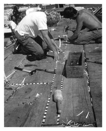
Fig. 2 Calfatage à base de mousse: cette dernière est recouverte par une latte de saule maintenue par des milliers de petits clous à large tête.
