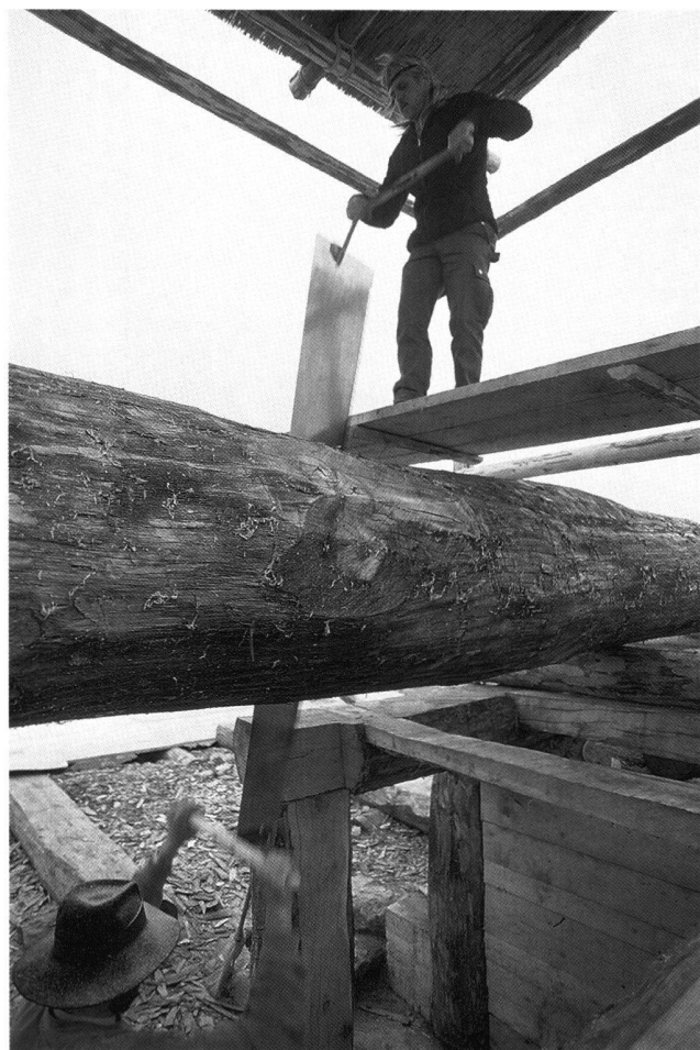
Fig. 3 Sciage de long à l'aide d'un cran.
