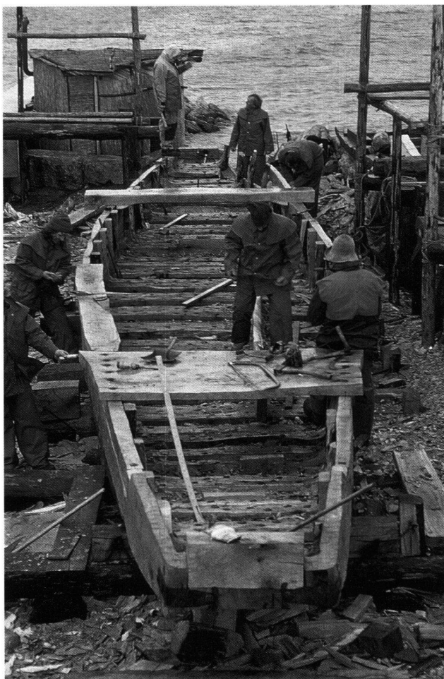
Fig. 1 Altaripa : réplique d'un chaland gallo-romain découvert à Bevaix pendant son assemblage.
