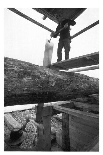
Fig. 3 Sciage de long à l'aide d'un cran.
