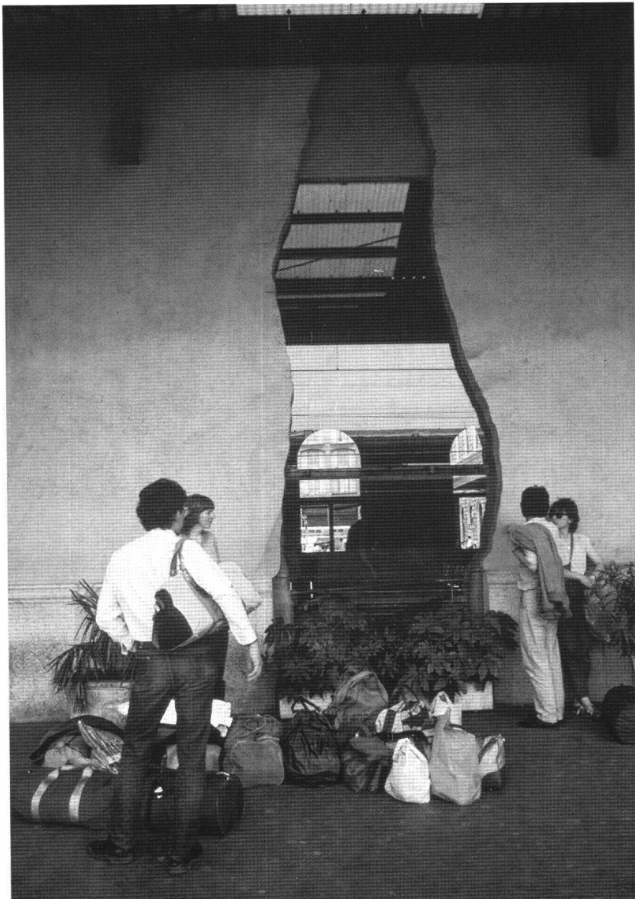
Abb. 1 Bologna, Hauptbahnhof, Denkmal des Attentats 1983.
